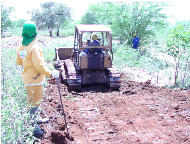
Foto 1. Remoção da Vegetação no Reservatório Moxotó Lote 11, Eixo Leste
