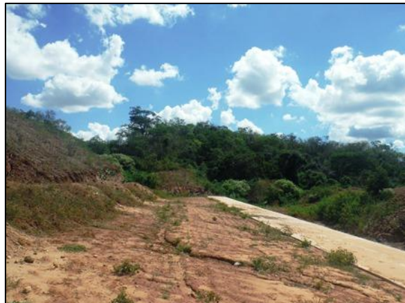
Foto 72 – Área de Preservação Permanente (APP) do curso d'água afluente do riacho Jurema com a estrutura da passagem da fauna (Abr/2017).
