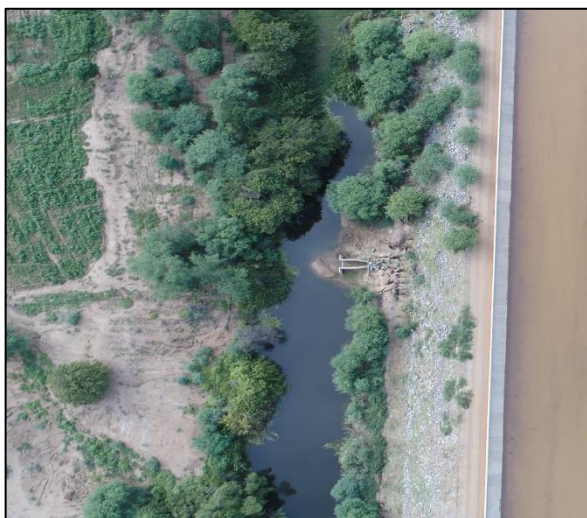
Foto 39 – Vista aérea do bueiro - PMPFN10 (Mar/2020).
