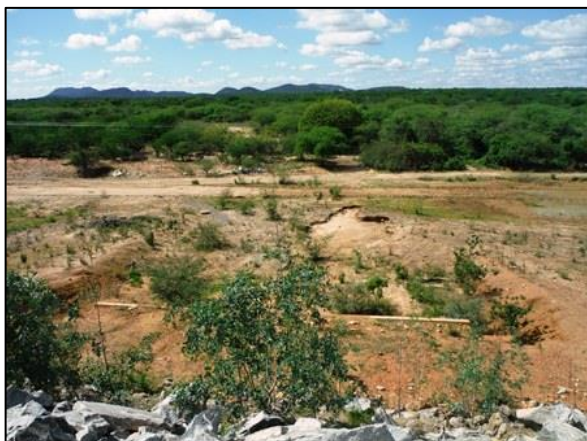
Foto 112 – Passagem de fauna no PMPFL12 (Abr/2017).
