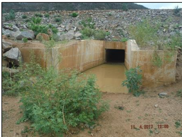
Foto 45 – Passagem de fauna do PMPFN 13 entre a Serra do Livramento e curso d'água afluente do riacho Salgueiro.
