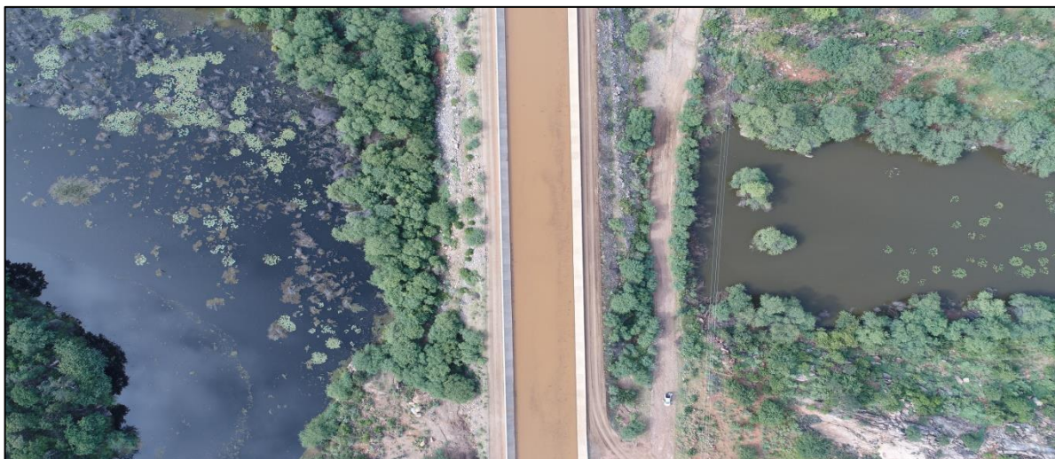
Foto 42 – Vista aérea do bueiro - PMPFN11 (Mar/2020).
