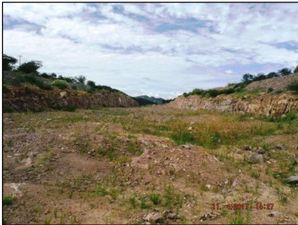
Foto 52 – PMPFN 16 sem estrutura para a passagem da fauna.
