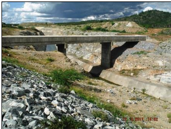
Foto 145 – Bueiro construído sobre o canal no PMPFL28.
