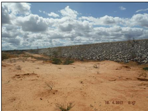
Foto 90 – A estrutura para passagem da fauna não foi construída no local.
