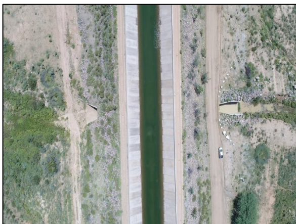
Foto 15 – Vista aérea do Bueiro - PMPFN 04 (Mar/2020).
