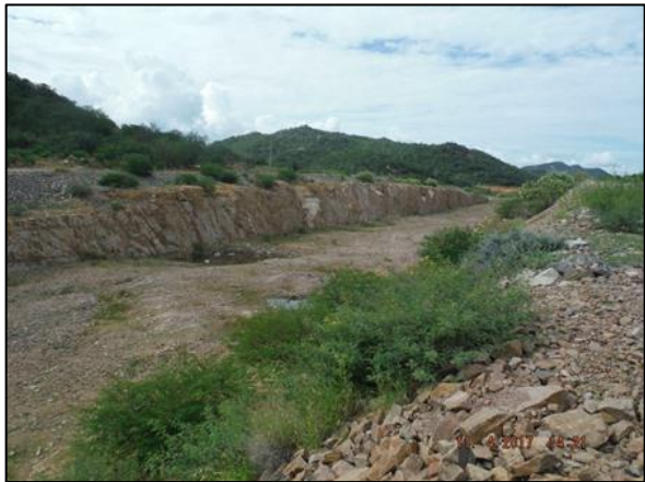
Foto 51 – PMPFN 16 sem estrutura para a passagem da fauna.
