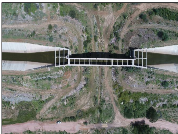
Foto 4 – Vista aérea do Aqueduto Logradouro - PMPFN 01 (Mar/2020).
