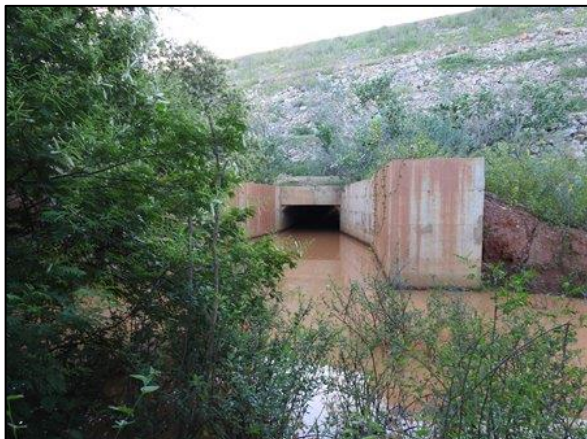
Foto 63 – Passagem de fauna no PMPFN22 ainda com acúmulo de água das chuvas (Abr/2017).
