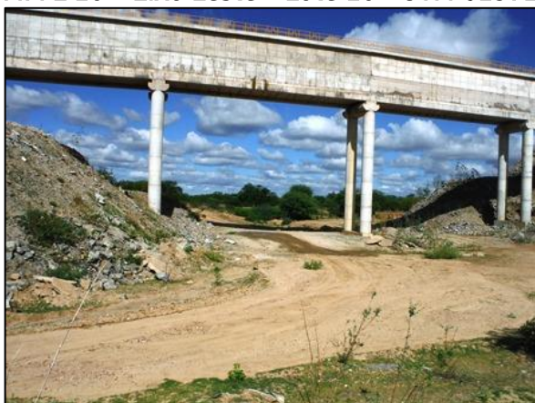
Foto 108 – Passagem de fauna no PMPFL10 (Abr/2017).
