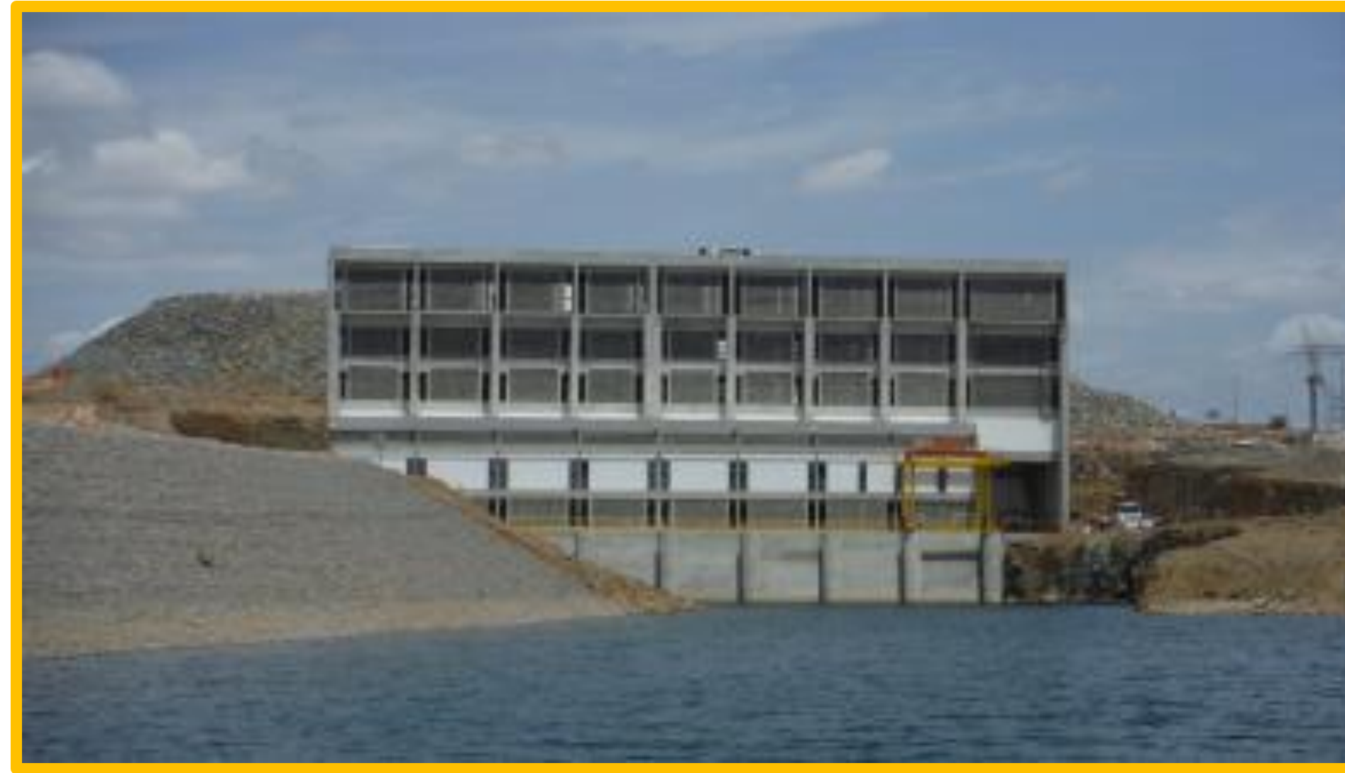
Estação de Bombeamento 1 do Eixo Norte
