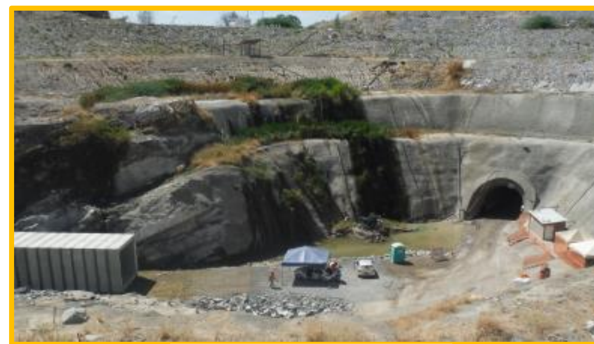
Desemboque do Túnel
