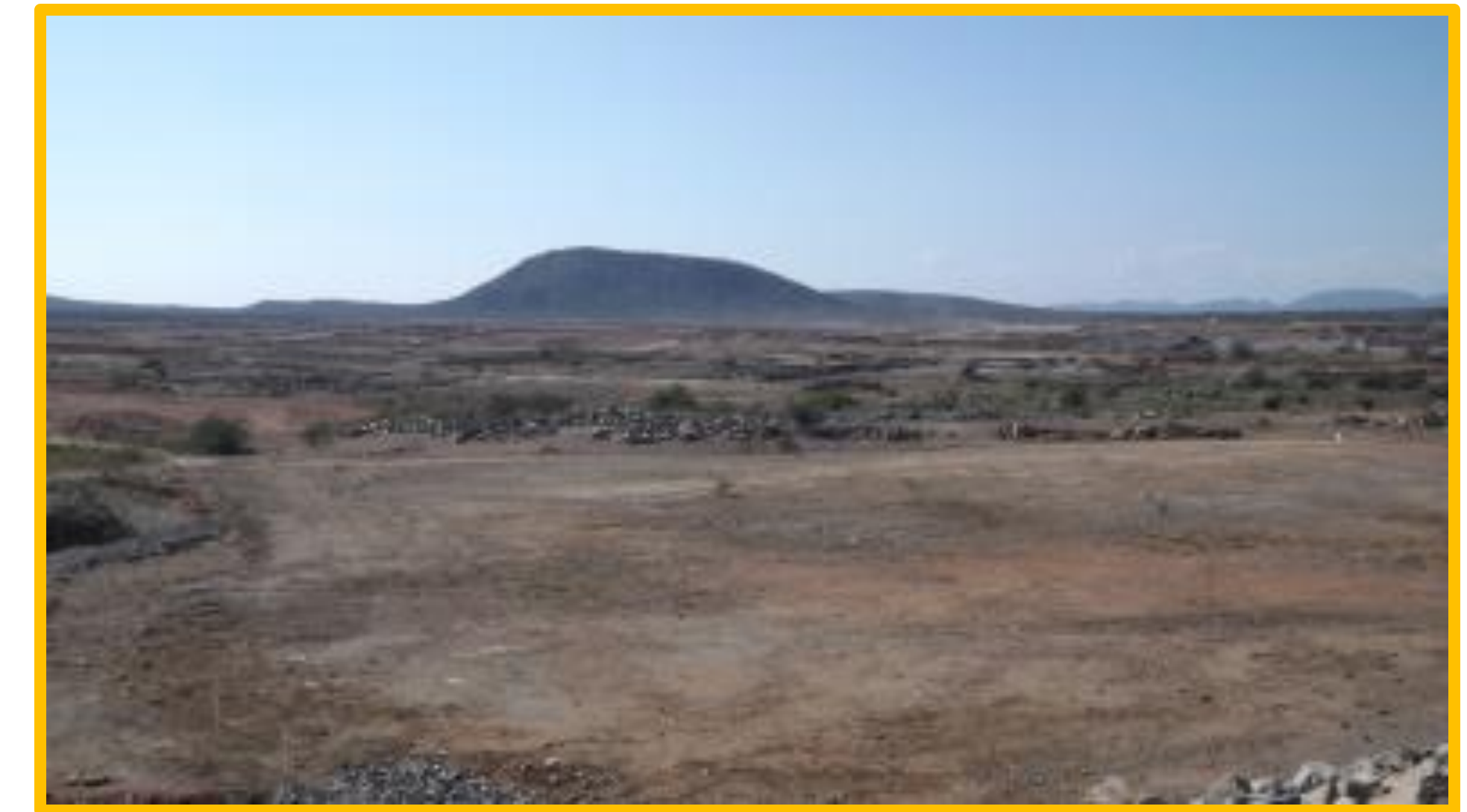
Reservatório Tucutu antes do enchimento (2008 a 2015)
