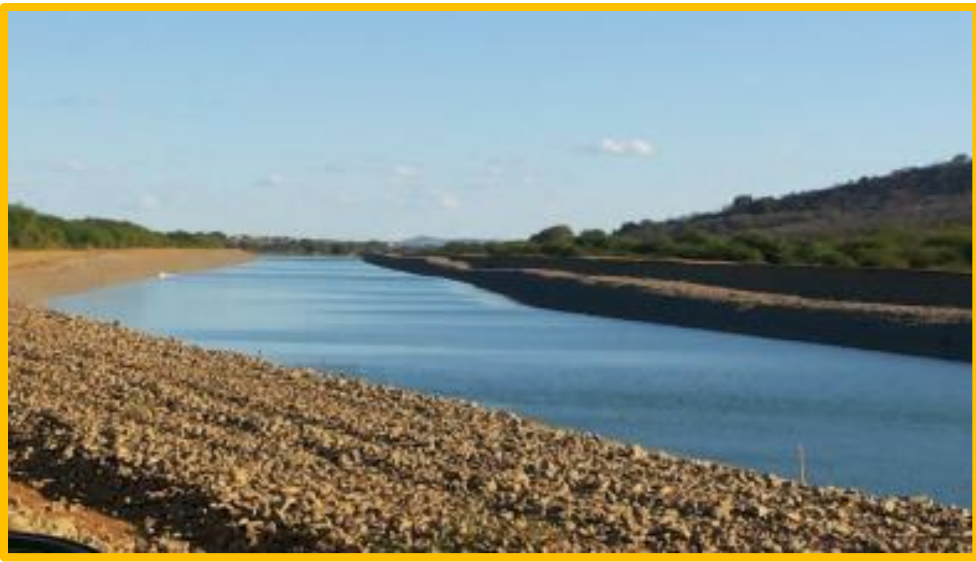
Captação de água do Eixo Norte
